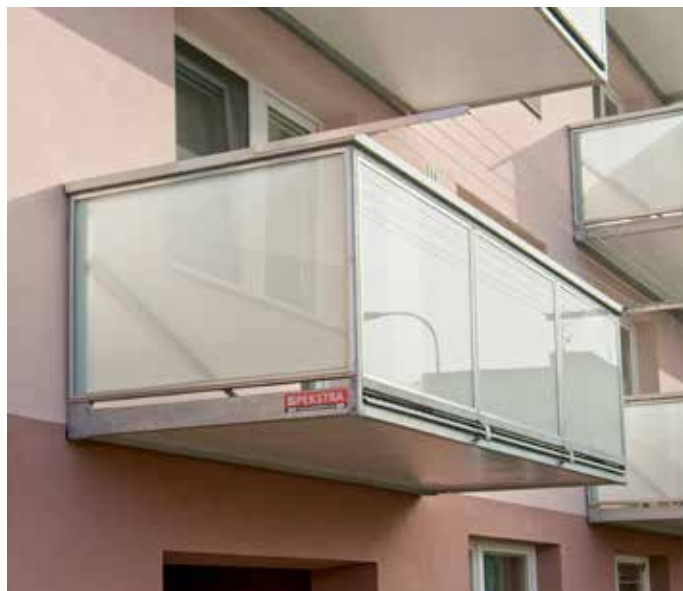
Kotvení balkonu bez mezery
