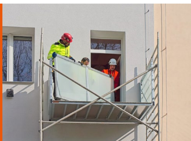
Závěrečné osazení čelního balkonového dílu.
