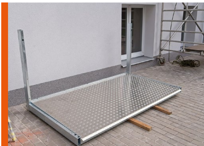
Sestavená základní nosná konstrukce balkonu pro osazení.
