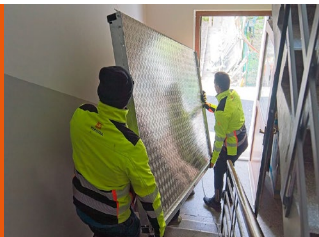
Přenesení podlahy balkonu do vnitrobloku domu.
