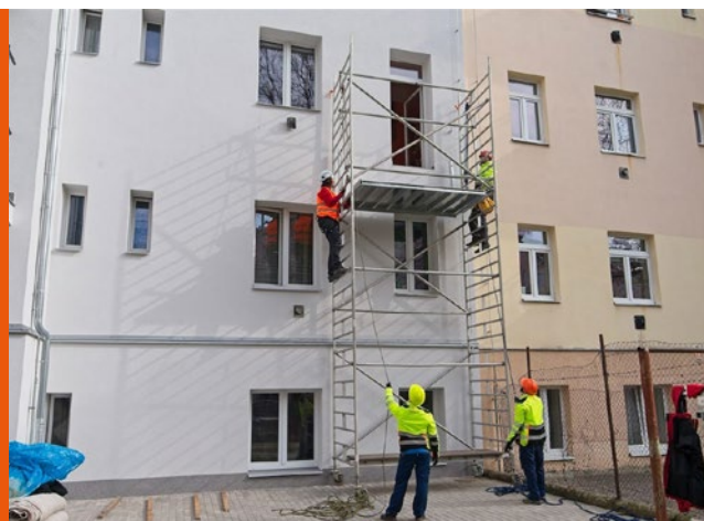
Vyzdvižení konstrukce na požadované místo zavěšení balkonu.
