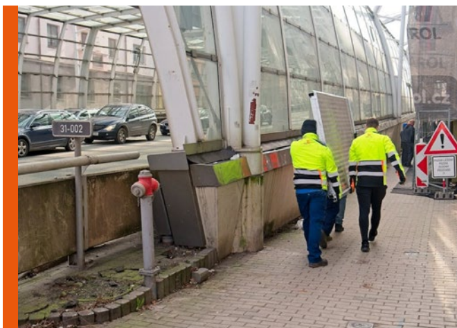
Manuální přesun jednotlivých dílů k bytovému domu, kde má být balkon osazen.
