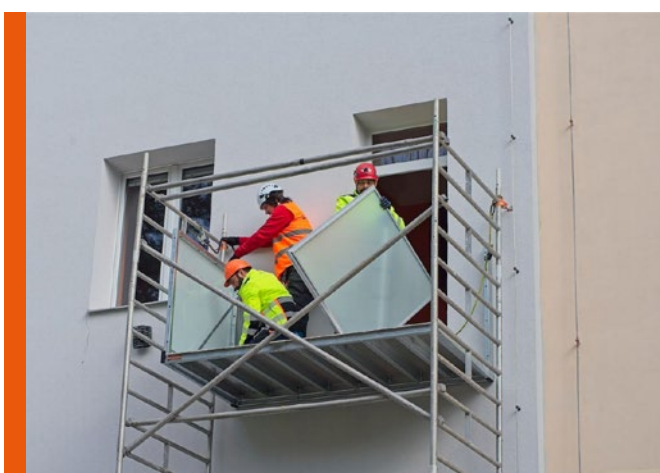
Montáž bočního zábradlí s výplní mléčným bezpečnostním sklem.
