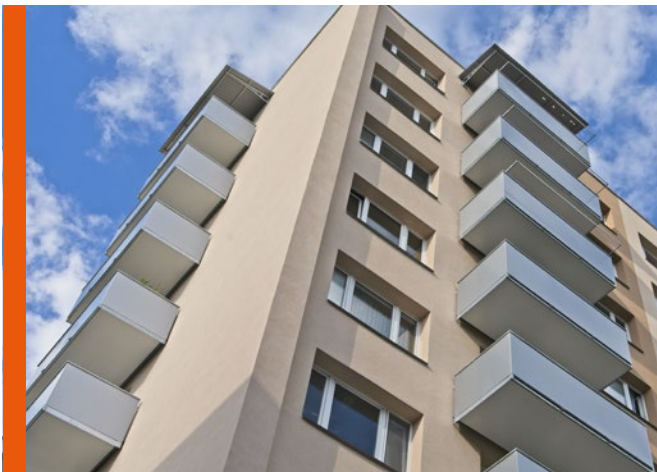
Plná výplň. Hladký nebo trapézový plech s polyesterovým lakem v různých barevných odstínech.
