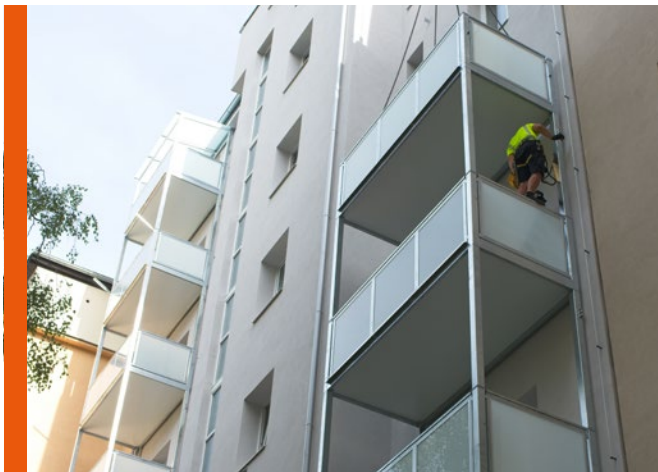
Lodžie se montují na betonový základ mimo nosnou stěnu domu.
