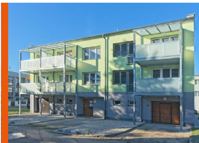
Samonosné lodžie lze realizovat i na bytové domy kde balkony nikdy nebyly.
